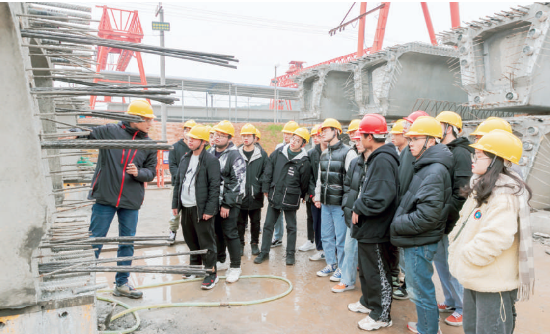
湖南交院学生到工地实训。
